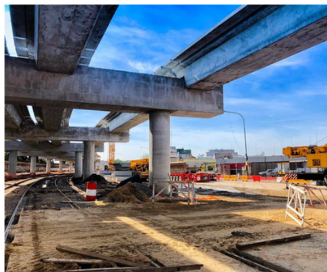
Viaducto en Construcción – Vigas Pretesadas Montadas
